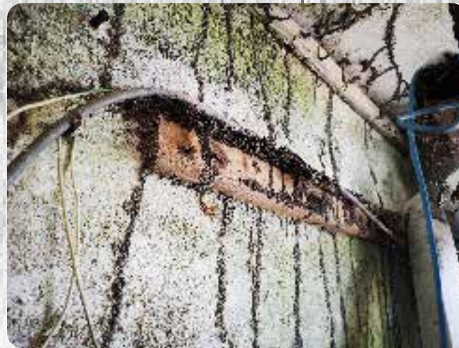
Canales de barro que construye Reticulitermes flavipes para acceder hasta el alimento.
